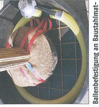
Ballenbefestigung an Baustahlmatte und Drainagerohr mit Walu-Endklappe. Foto: Gugenhan
