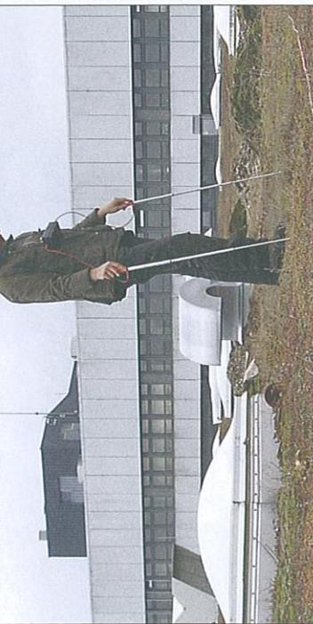
Mit dem Elektro-Impuls-Verfahren werden Lecks in der Abdichtung von Flachdächern aufgespürt, ohne Auflastungen zu entfernen. Foto: re-natur
